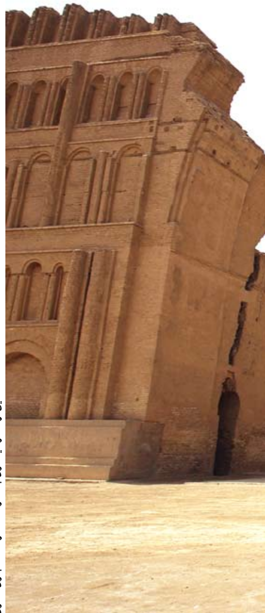
نمایی از قصر تیسفون با حدود ۲۵ متر دهانه بدون ستون
